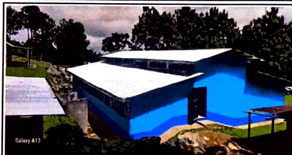
Foto 2: MUESTRA DEL TECHO NUEVO Y COLOR DE PINTURA UTILIZADO
