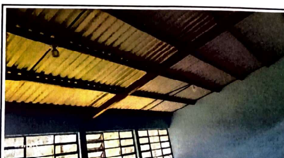
Foto 6: MUESTRA DE INSTALACION ELECTRICA EN EL AULA
